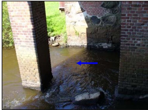
Auslauf der 1,5 m 3 /s Turbine rd. 5 m ins Gebäude hinein versetzt
