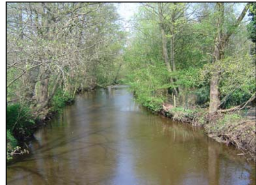
Wümm bei Stat. 50+100 (Hetzweiger Str./L 131) im Rückstaubereich mit vergleichmäßigten Sohl- und Sohlströmungsstrukturen
