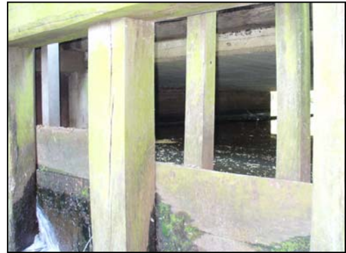
Blick vom Wehr unter die Brücke der K 216
