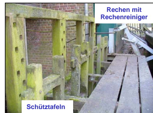
Schütztafeln, Bedienungssteg und Rechen mit Rechenreiniger
