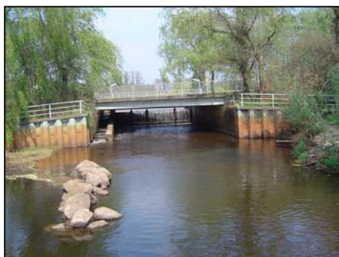
Klappenwehr mit Beckenpass vom UW
