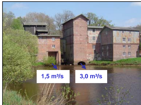
Mühle vom Unterwasser
