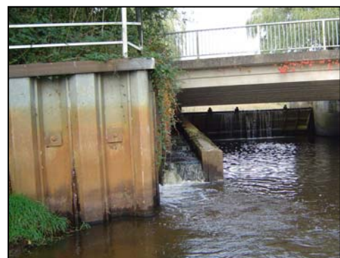
Einstieg zum Beckenpass ( \Delta H_w \sim 0,3 m)
