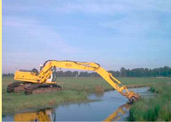
Bagger bei der Grabenräumung (Brem. Deichverband)
